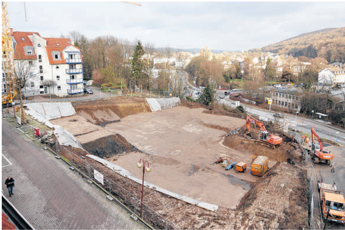
Hier baut die Stiftung Noss-Haas zwei Gebäude mit 32 barrierefreien Wohnungen.
